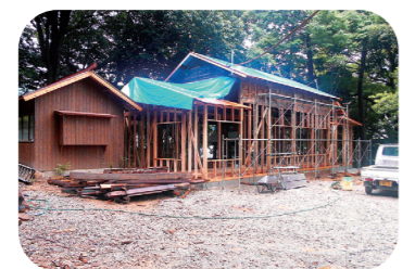
改修が進む社務所
