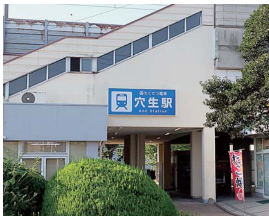
エレベーター設置予定の下り線側穴生駅
