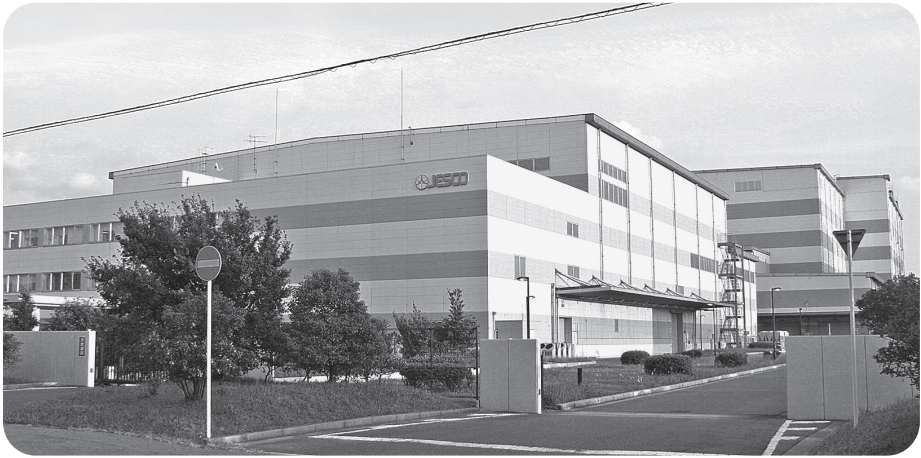
（事故隠しが相次いで発覚している、若松区のPCB処理施設）
