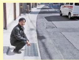
内水氾濫対策の側溝設置
