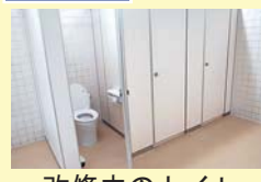
改修中のトイレ
