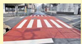
通学路の安全対策のためのカラー舗装
