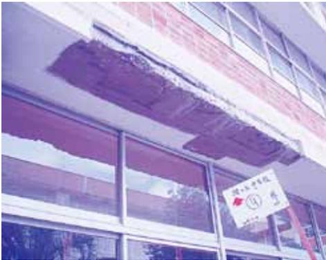
8/17「学校ウォッチング」で指摘されている門司区緑ヶ丘中学校1階の鉄筋爆裂箇所
