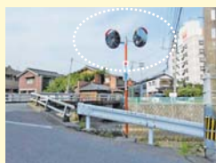
カープミラー設置
