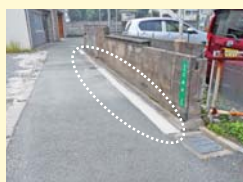
江南町側溝設置
