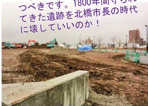
造成工事が進む東エリア (3月)
