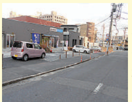
道路が拡幅される
