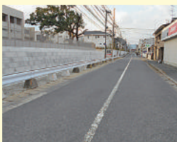
歩道が拡幅される
