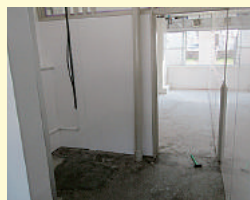
トイレが改修される
