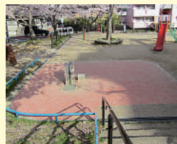
水道床面の設置
