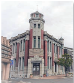
旧古河鉱業若松ビル
