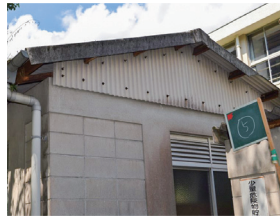
↑屋根の素材にアスベスト使用疑い
