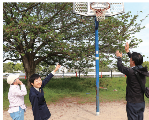
住民要望が実現し、修繕されたバスケットゴール
